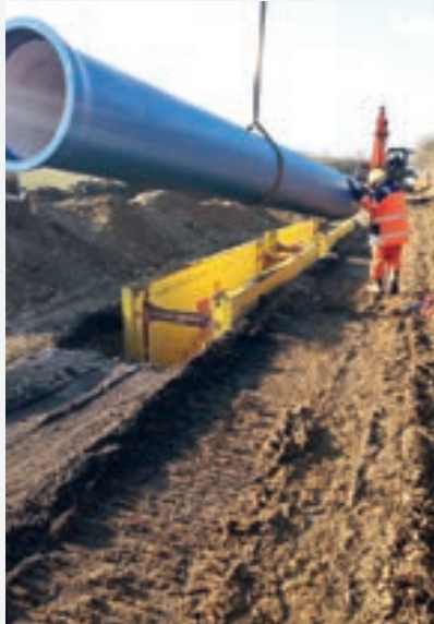
Leichtverbau Einsatz Kanalbau
