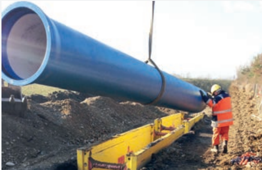
Leichtverbau 600 Einsatz Kanalbau
